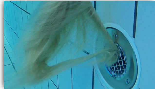
Einströmöffnung Ansaugwirkung nach Injektorprinzip
